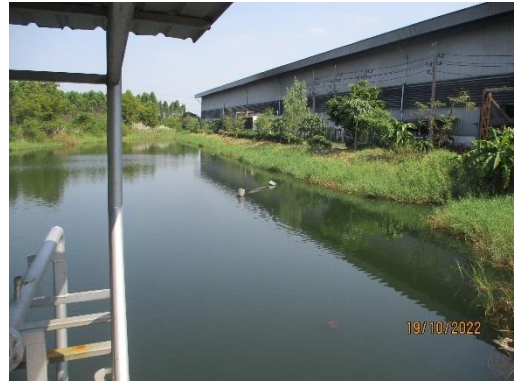
บ่อพักน้ำ 2 ความจุ 23,400 ลูกบาศก์เมตร
