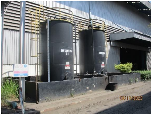
รูปที่ 15 คันกันคอนกรีตรอบถังเก็บน้ำมันเตา
