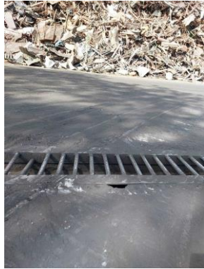
รูปที่ 19 รางระบายน้ำรอบกองเหล็ก
