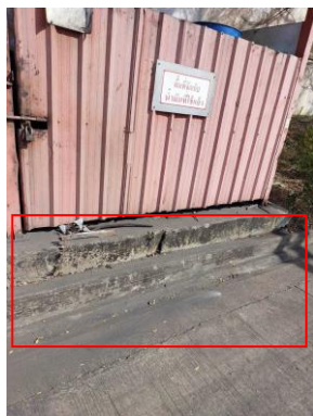
รูปที่ 21 รางรับน้ำรอบพื้นที่กักเก็บน้ำมัน
