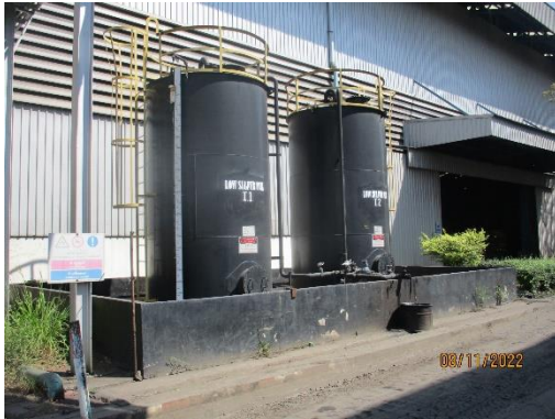
รูปที่ 54 ถังเก็บน้ำมันเตา
