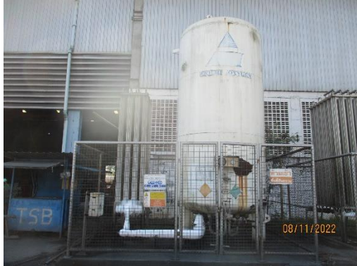
รูปที่ 49 การกักเก็บออกซิเจนเหลวในพื้นที่โครงการ
